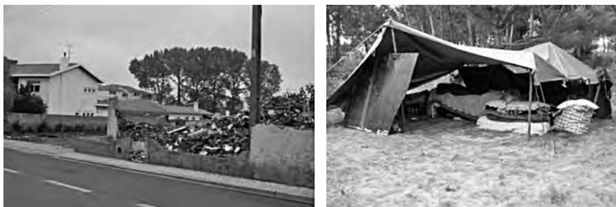
Foto 5: Demolição da casa ocupada pela família de Leila e tenda de Pablo após a saída da casa
